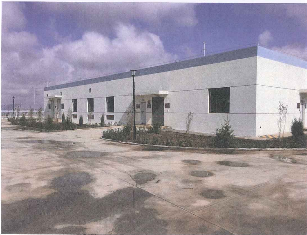
35kV 开关站内绿化完成情况
