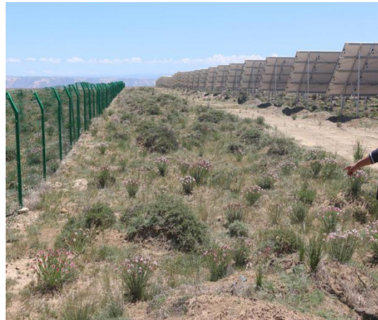
工程占地范围网围栏圈闭后施工
