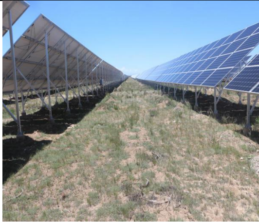
光伏场区植被恢复现状
