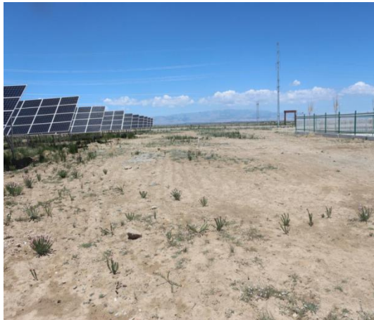
施工营地拆除后场地平整恢复
