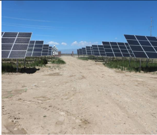
施工期平整压实的场内道路
