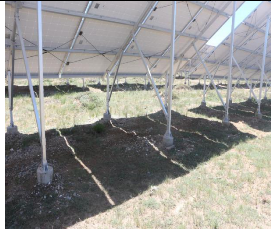
光伏场区植被恢复现状
