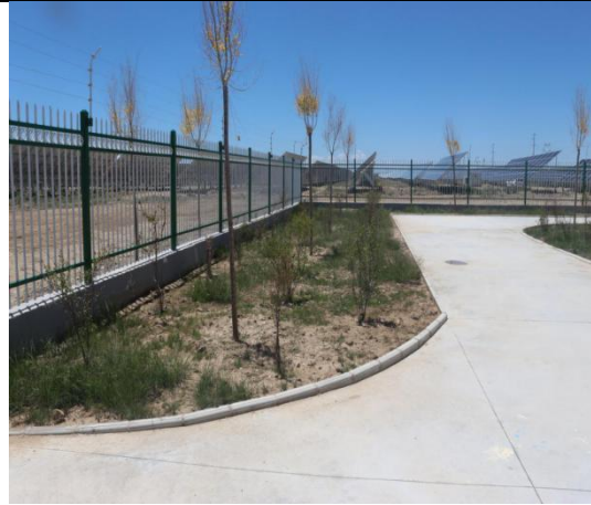
厂区内道路硬化
