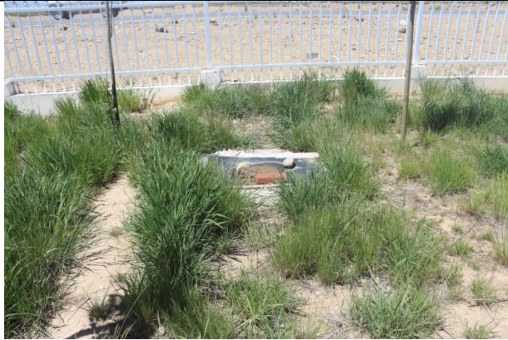
项目依托洪昇共和光伏电站内 29m 3 化粪池
